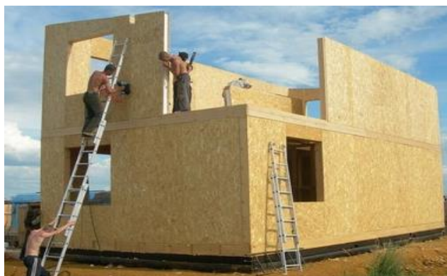
Рис. 7. Конструкционно-изоляционная панель (SIP)
