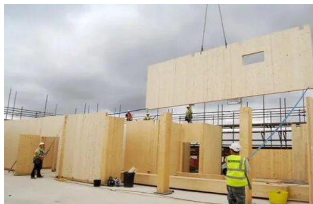
Рис. 3. Устройство CLT-панели, технология строительства
